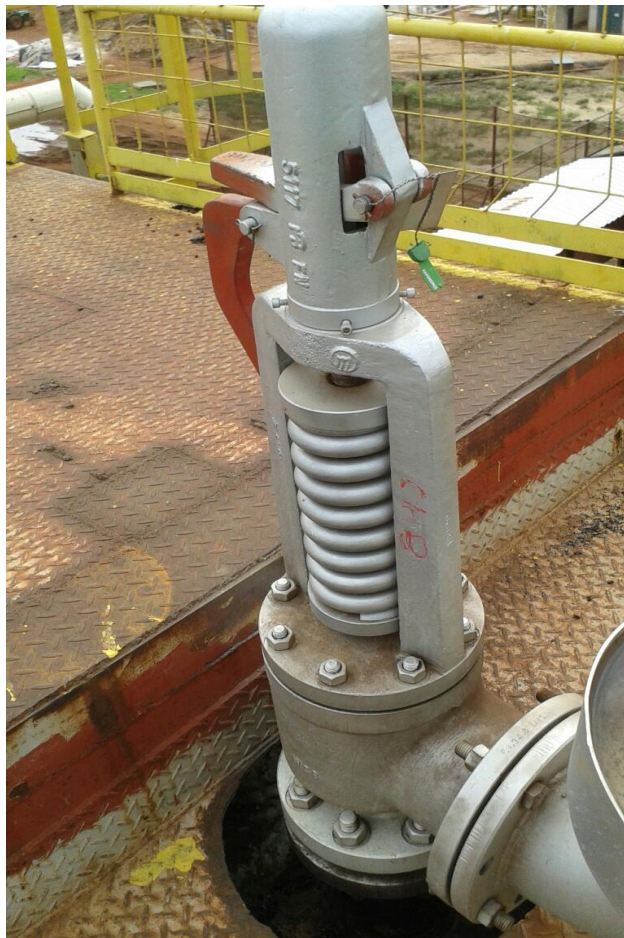
Fonte: Usina Nova Gália FIGURA 7 – Válvula de Segurança caldeira aquatubular.
