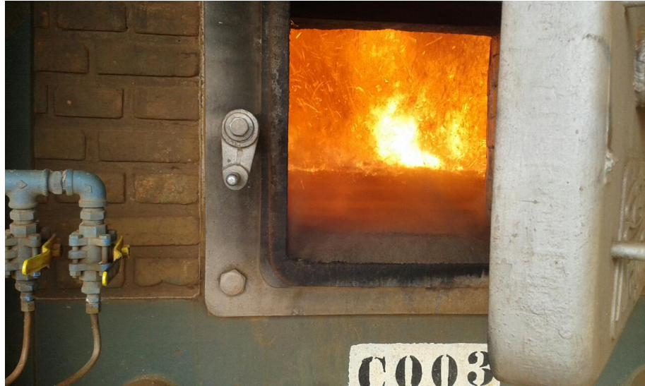
FIGURA 3 – Fornalha de caldeira aquatubular.
