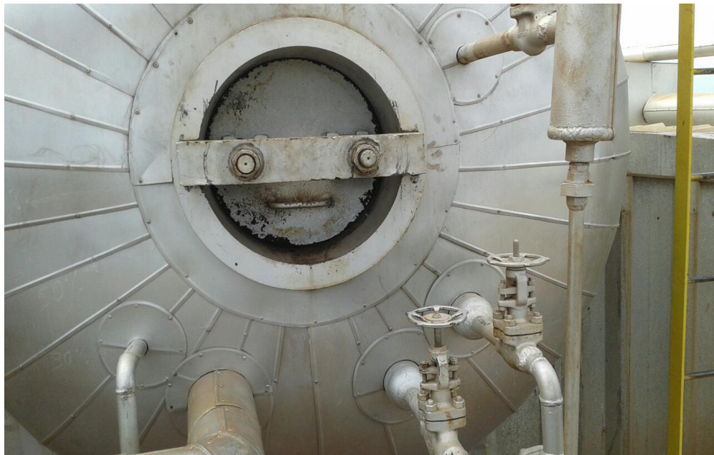
FIGURA 5 – Tubulão superior de caldeiras aquatubular.
