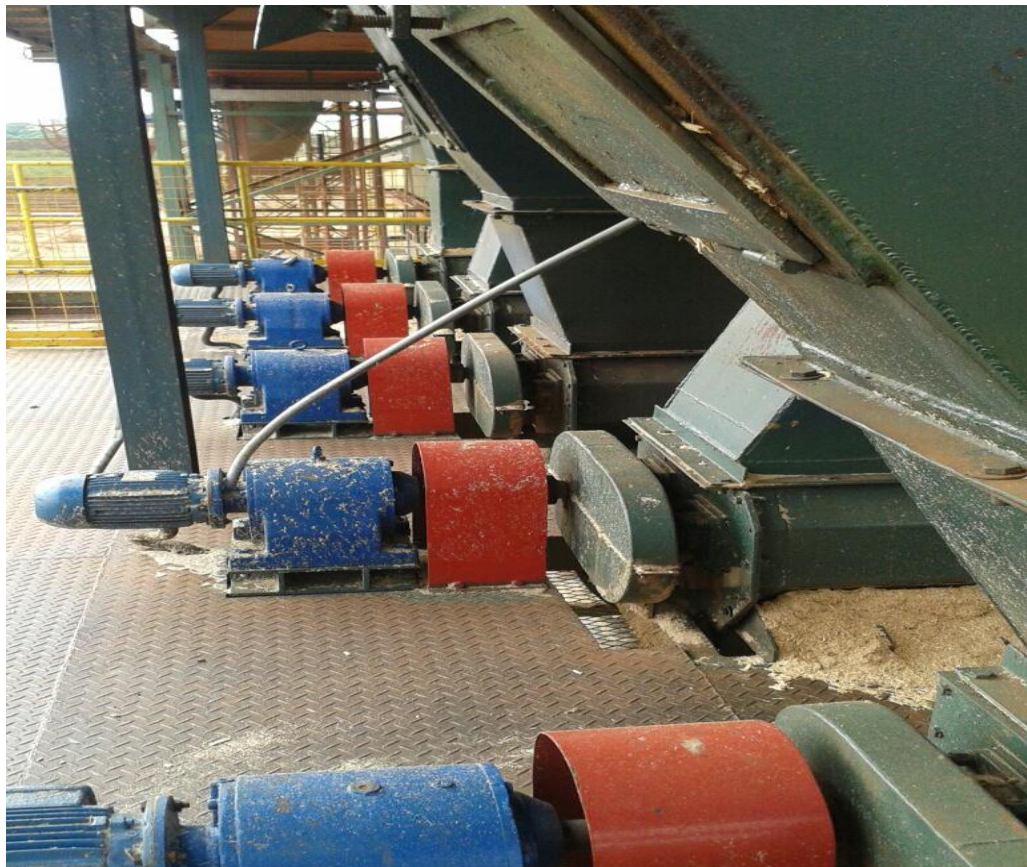
FIGURA 4 – Alimentador de combustível de cadeira aquatubular.
